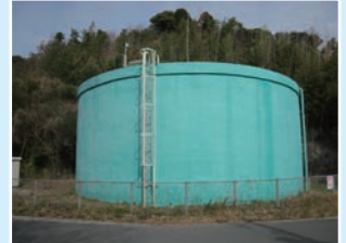
かんのんじ 観音寺配水池：1100 m 3
